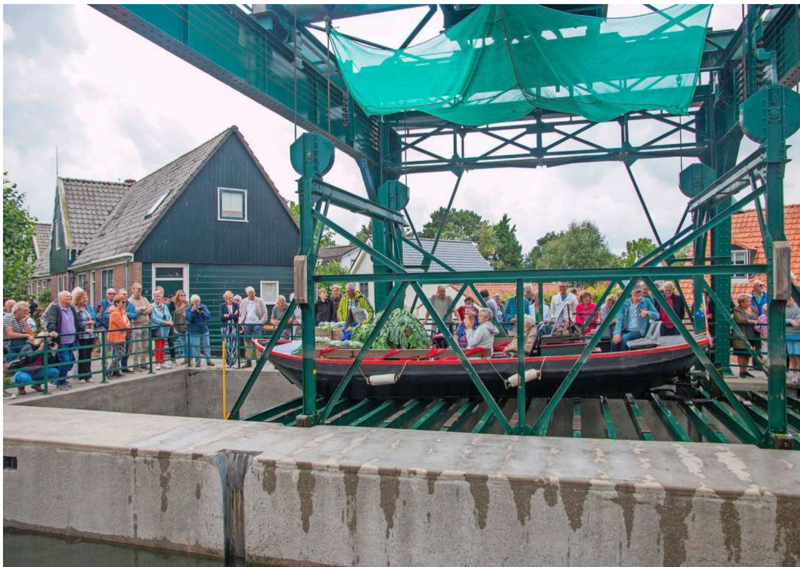
Onder grote belangstelling worden de schuiten met de Overhaal overgezet vanuit de polder.
